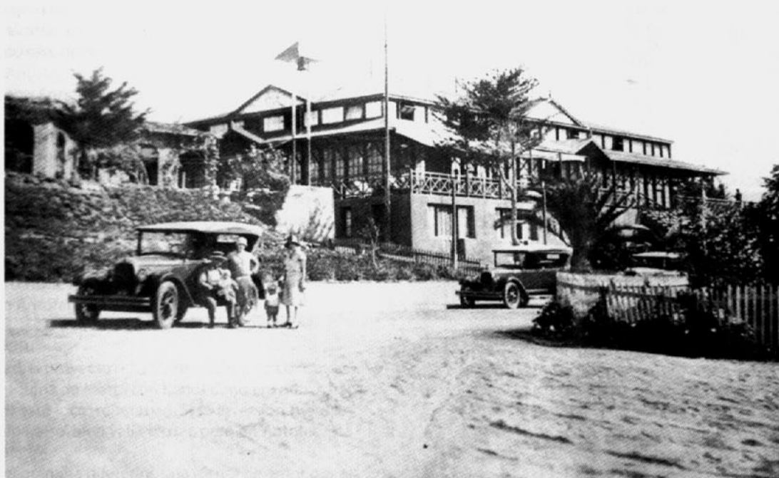
EL ANTIGUO EDIFICIO DEL AUTOMÓVIL CLUB DE ANTOFAGASTA FUE CONSTRUIDO COMPLETAMENTE DE PINO OREGÓN.
