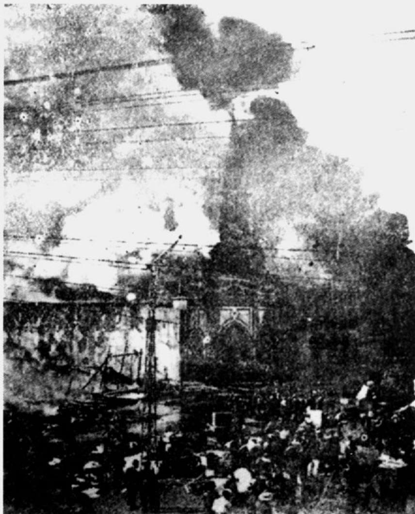
INCENDIO QUE DESTRUYÓ LA CATEDRAL EN 1906.
