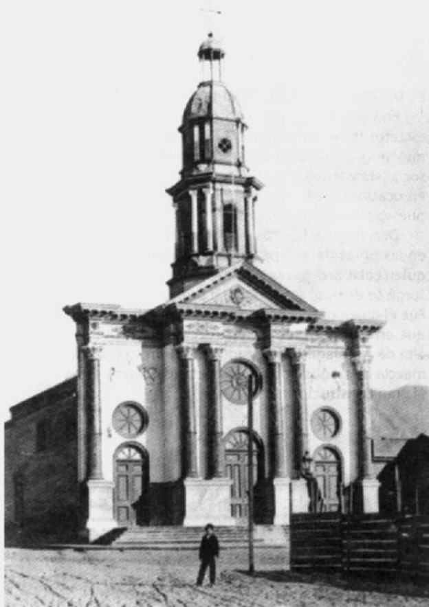
LA IGLESIA CORAZÓN DE MARÍA Y SU PRIMER TEMPLO CONSTRUIDO EN MADERA EN 1903. SE INCENDIÓ EN 1912. TARDÓ QUINCE AÑOS SU RECONSTRUCCIÓN.
