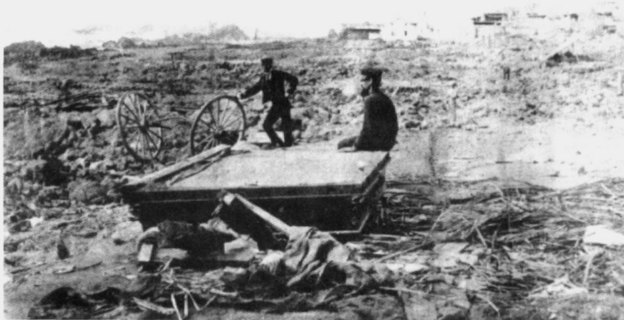
EL MAREMOTO DESTRUYÓ TOTALMENTE EL PUERTO DE COBIJA. ASÍ SE PUEDE OBSERVAR EN ESTA FOTOGRAFÍA.
