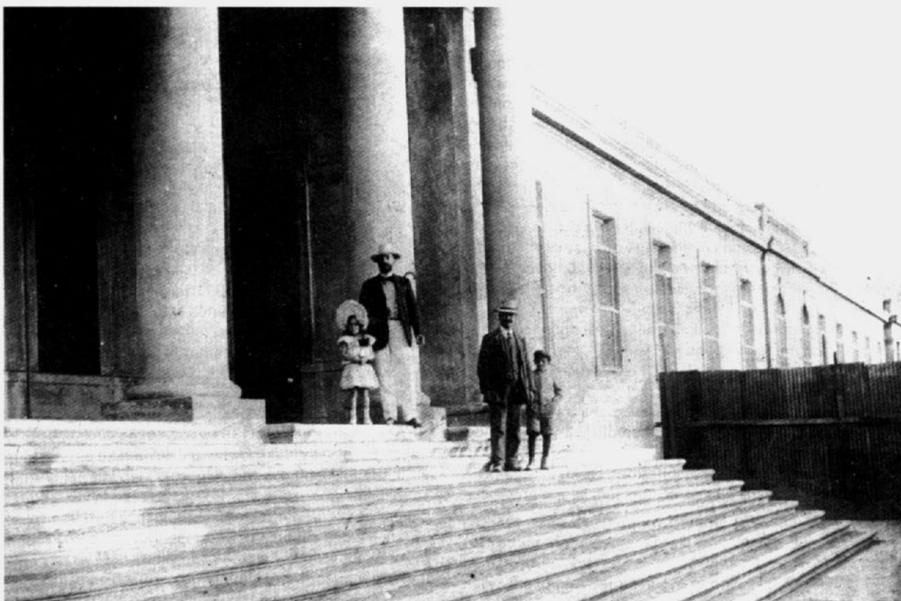
LA ENTRADA PRINCIPAL DEL HOSPITAL DEL SALVADOR, CON SUS CUATRO GRANDES COLUMNAS QUE SE ELEVAN AL CIELO, AÚN SE MANTIENEN EN PIE.
