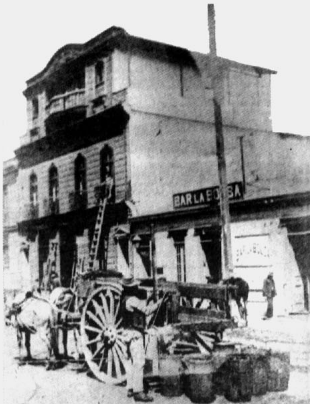
CARRETA CON ABRÓMICOS REALIZANDO SU SERVICIO EN LA CALLE BAQUEDANO
